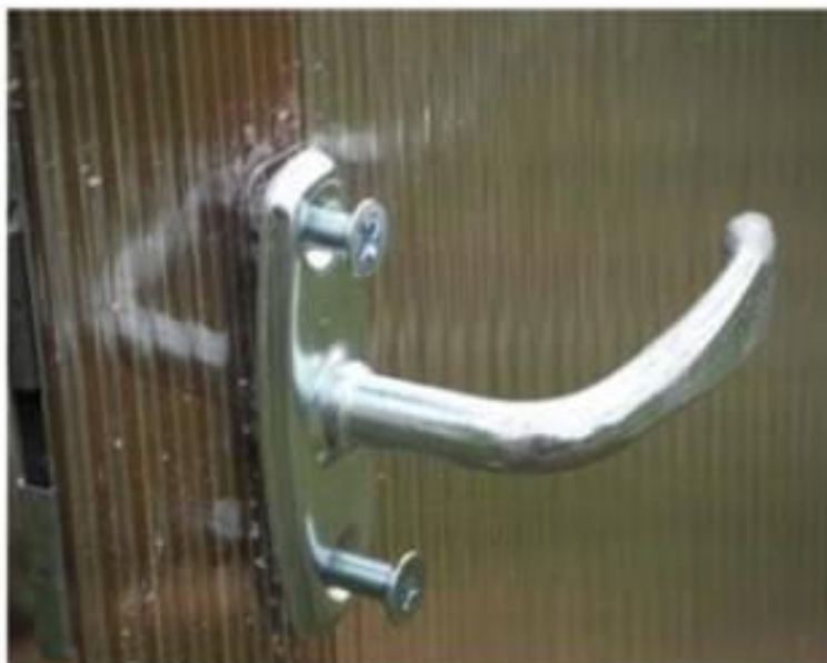
Крепление саморезами по металлу.
